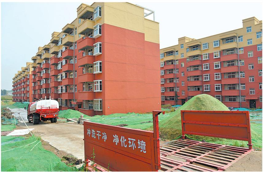
10月19日上午,在石龙区观湖佳苑公共租赁住房住宅小区项目施工工地,裸露的地面和土堆加盖了防尘网。该项目是石龙区政府投资建设的第一个集住宅、商业、幼儿园于一体的公共租赁住房小区,建成后容纳1100户居民。为确保有郊抑尘,防止施工过程中造成大气污染,该工程从开工伊始就做好防尘抑尘工作,对裸露地面加盖防尘网,设立防尘雾炮、车辆冲洗设备等。
