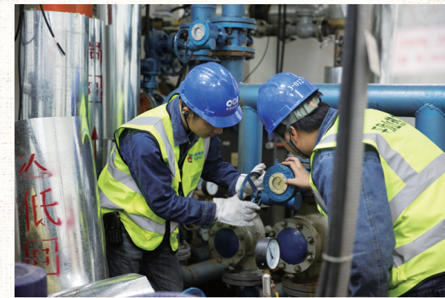
工作人员在现场调试热力设备
