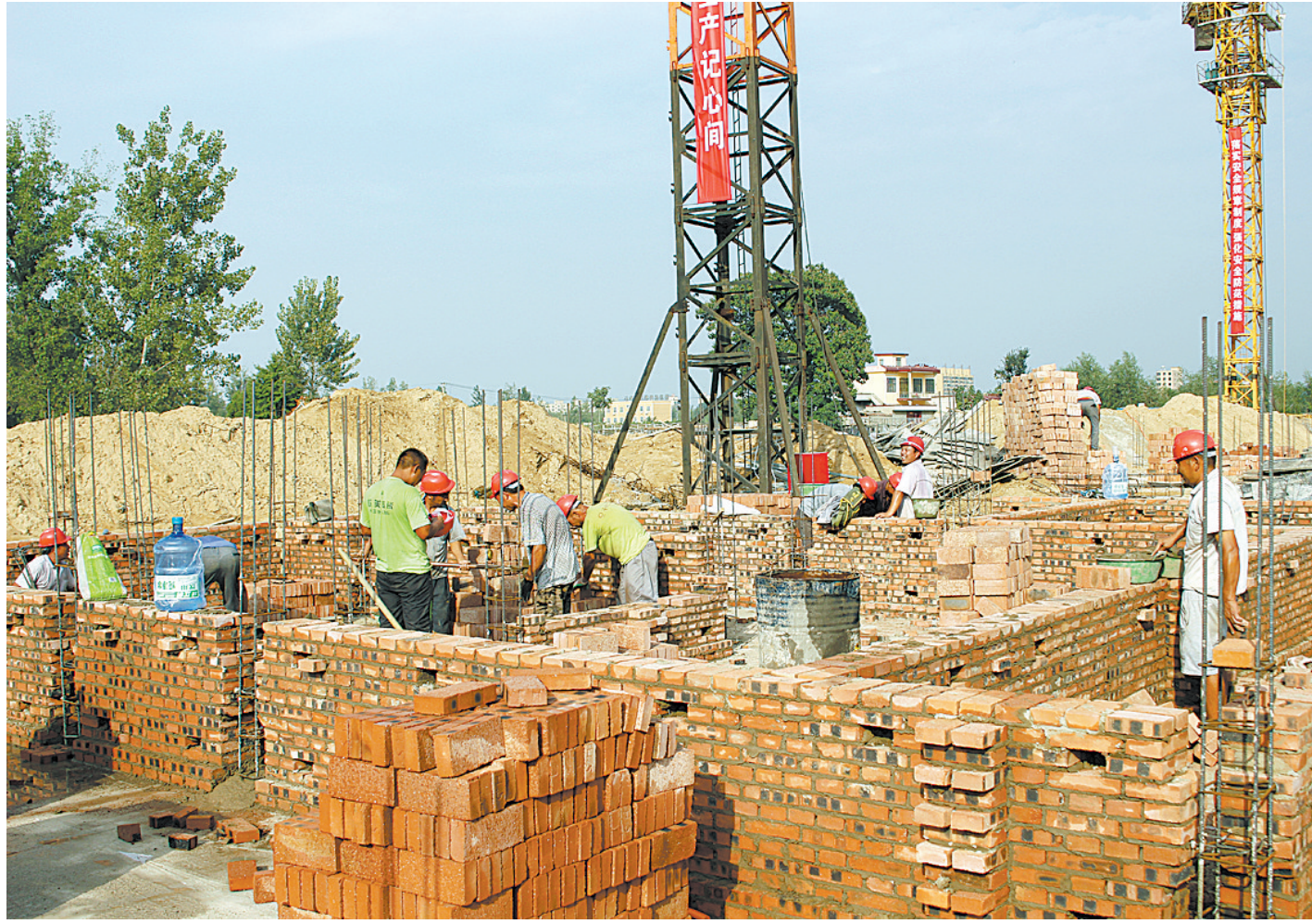
9月22日,建筑工人在张良镇周楼村的易地搬迁扶贫项目工地上干得热火朝天。在全县脱贫攻坚百日会战中,梁洼镇、张良镇、土门办事处等乡(镇、办事处)超前规划,精心运筹,协调了充足的人力和工程机械投入易地搬迁扶贫项目中。
