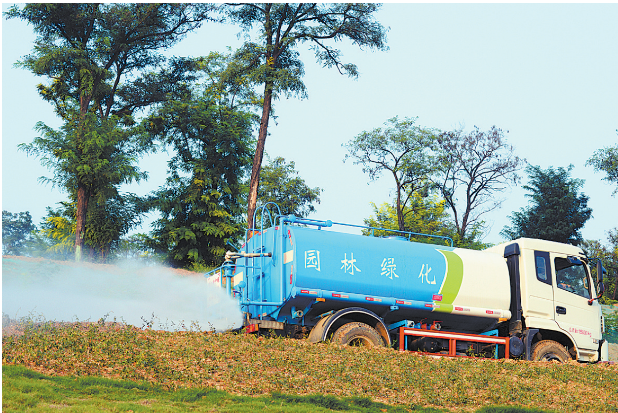
9月21日,工作人员驾驶洒水车在湛河治理景观绿化工程高压沟至李苗路标段工地沿施工道路实施水雾抑尘作业。为做好大气污染防治工作,该标段建设单位安排专人驾驶洒水车定时开展水雾抑尘作业,努力消除建筑扬尘隐患。 本报记者 王尧 摄
