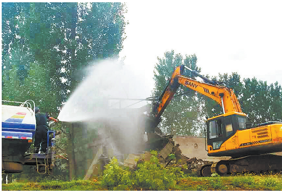
9月18日,工作人员开启高压水枪对位于高新区神马大道东段南侧一处建筑拆除现场实施降尘作业。
