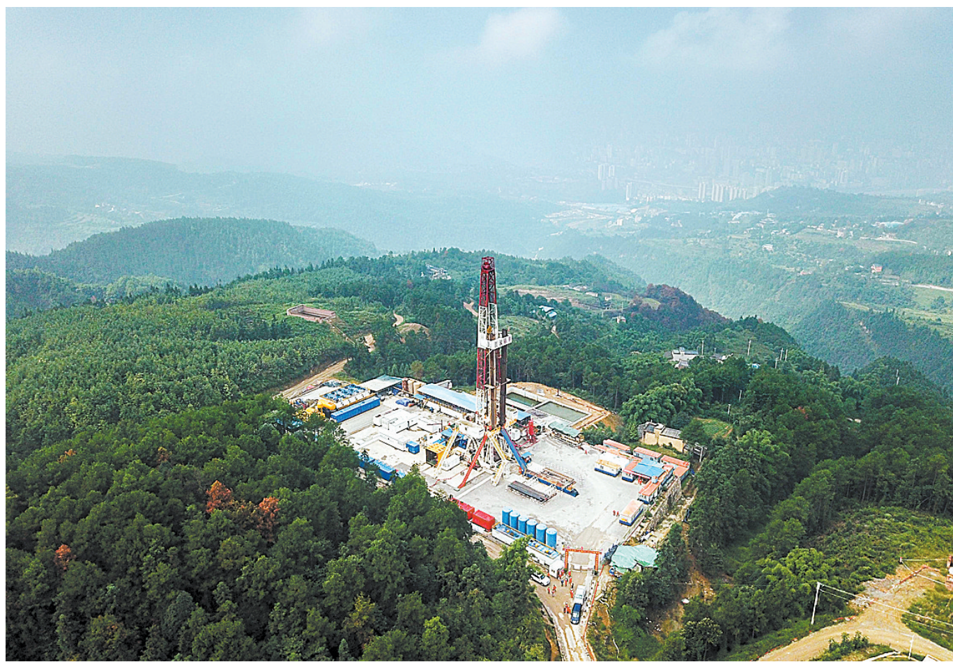
这是正在进行钻井作业的重庆涪陵焦页90号页岩气平台（9月7日摄）。 新华社发
