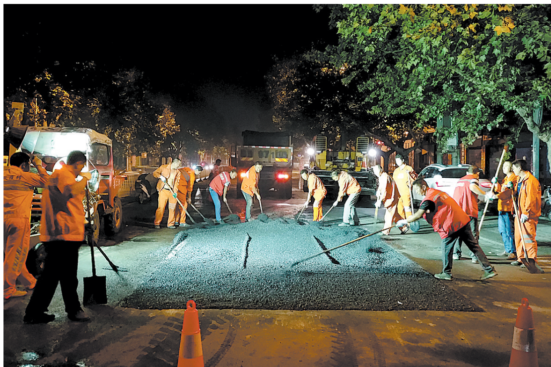
9月6日夜,市城管处市政维修管理队的员工在市区东段路维修路面。连续阴雨天气加上车辆碾压导致市区部分路面损坏,为防止雨后扬尘造成空气污染,市城管处市政维修管理队自当日开始
