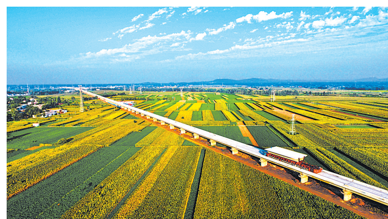
雨过天晴施工忙
