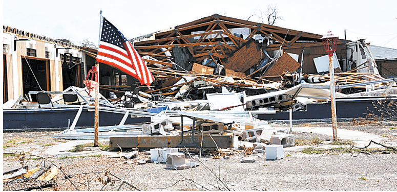
这是9月3日在美国得克萨斯州洛克波特镇拍摄的在飓风中受损的房屋。新华社记者 刘立伟 摄
