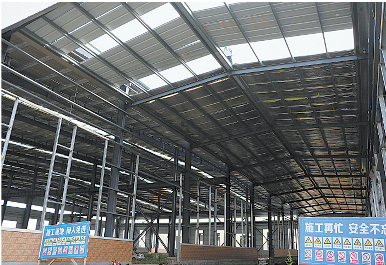
8月24日,在河南智豚金属制品有限公司,施工工人正在安装顶棚。这是由郟县堂街镇招商引资、入驻郟县产业集聚区的一家机械装备项目,总投资2.6亿元,于去年底开工,预计今年9月底竣工投产。投产后,该公司高档金属制品年产值将达到1.6亿元。 宁建鹏 摄
