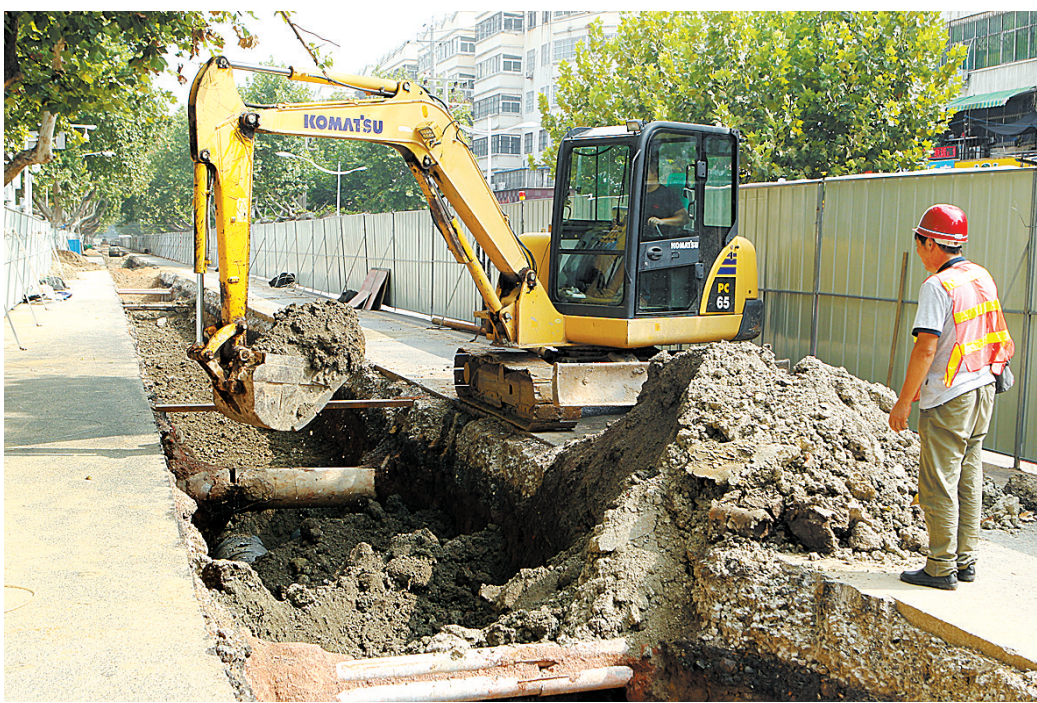
集中供热管网扩建工程加紧推进
