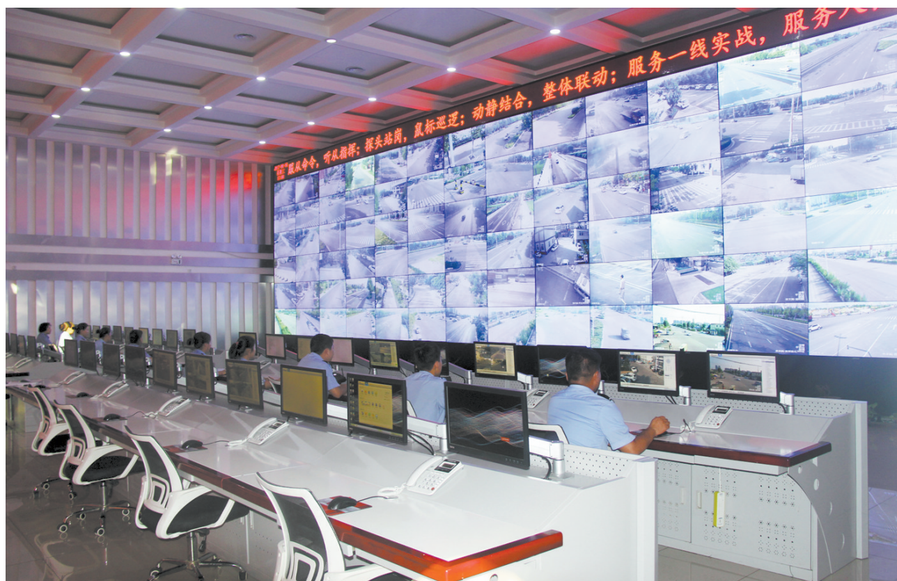
新城派出所视频监控中心。
