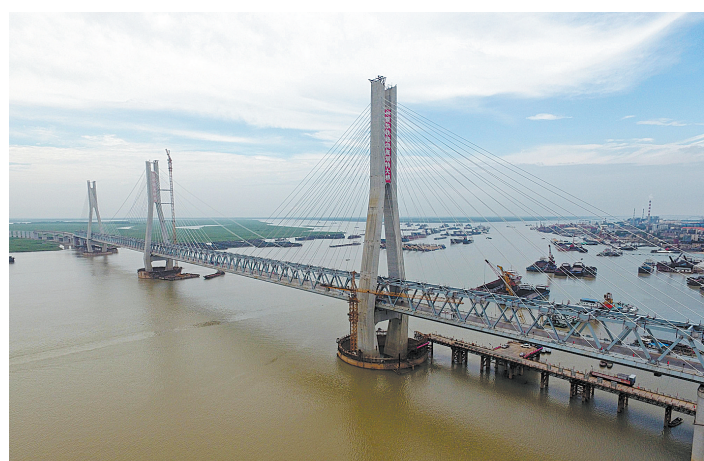
蒙华铁路洞庭湖大桥主体工程完工
