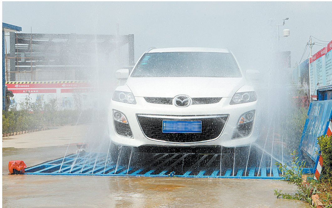
8月11日,一辆机动车在开源路高速引桥一在建项目工地出口处进行冲洗。为了做好环境污染防治工作,避免车辆携带污泥驶出工地造成扬尘,该项目施工方在施工现场出口处安装了重力感应喷淋系统,对所有出工地的车辆进行喷淋清洗。
