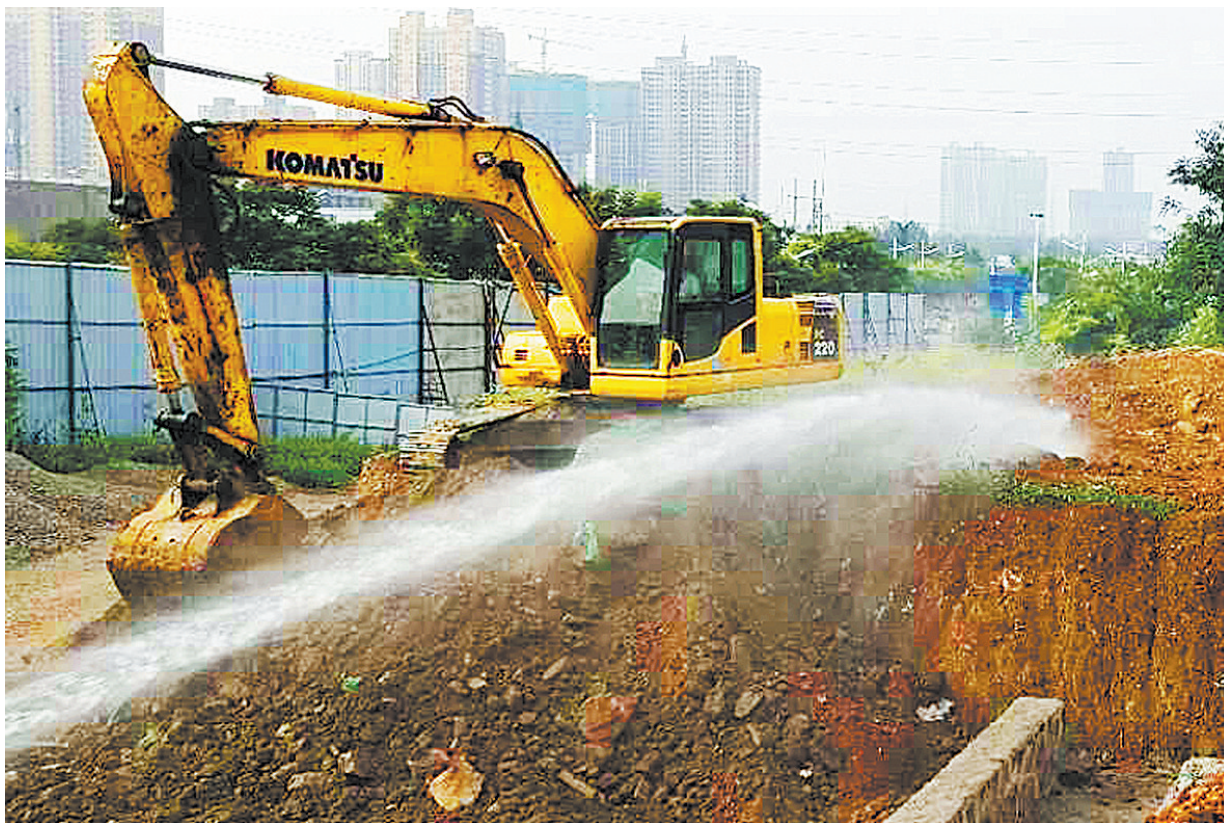
8月11日,市区凌云路西侧淇河治理工地施工人员进行架设水雾抑尘装置配合挖掘机开展“湿法作业”。
