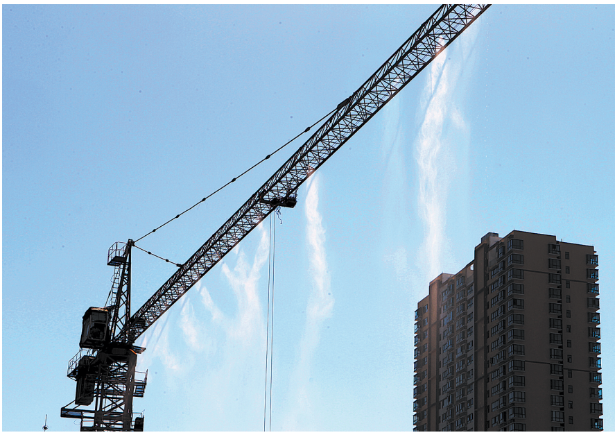
8月10日,建设路中段原宝华商场附近一建筑工地在利用塔吊喷淋系统喷雾抑尘。
