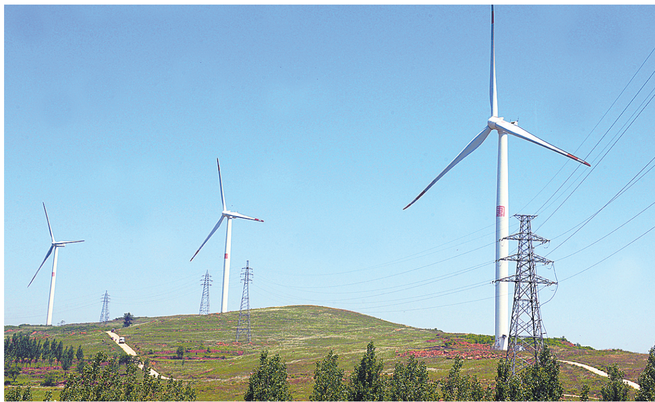
8月9日,一辆汽车从大唐唐县风力发电有限公司云阳风电场一期工程风电机组旁驶过。云阳风电场一期工程位于唐县境内的紫云山上,共有风力发电机组17台,装机容量34兆瓦。截至目前,该项目17台机组已全部并网发电,年发电量达7100万千瓦时,平均每年可减少二氧化碳排放6.6万吨,减排二氧化硫、粉尘等污染物将近1200吨。
