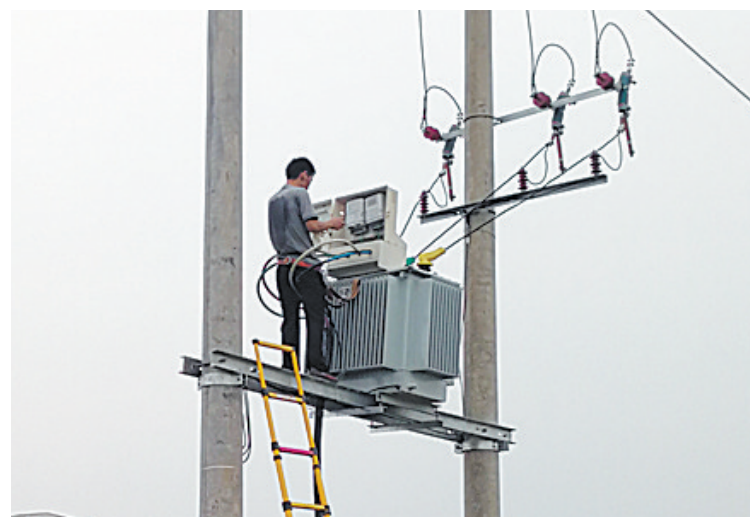
8月7日中午,电力技术人员在为光伏发电设备并网。 冯晓东 摄
