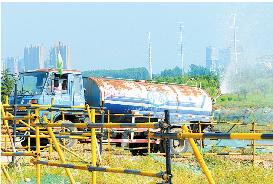
7月27日,一辆洒水车在位于西环路东侧的姚孟湛河桥项目工地洒水抑尘。为做好大气污染防治工作,该项目建设单位使用防尘网对裸露地表进行覆盖,并安排洒水车定时对施工道路、土方作业区域等扬尘防治重点区域洒水抑尘,努力消除工地扬尘隐患。
