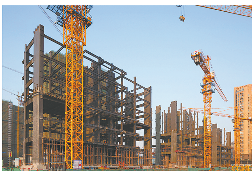
正在施工建设的第三代钢结构住宅建筑
