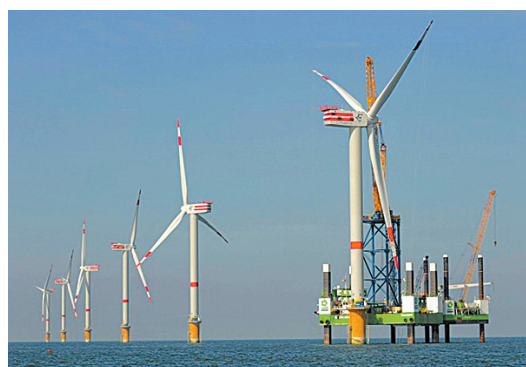
承建的海上风电桩基工程
