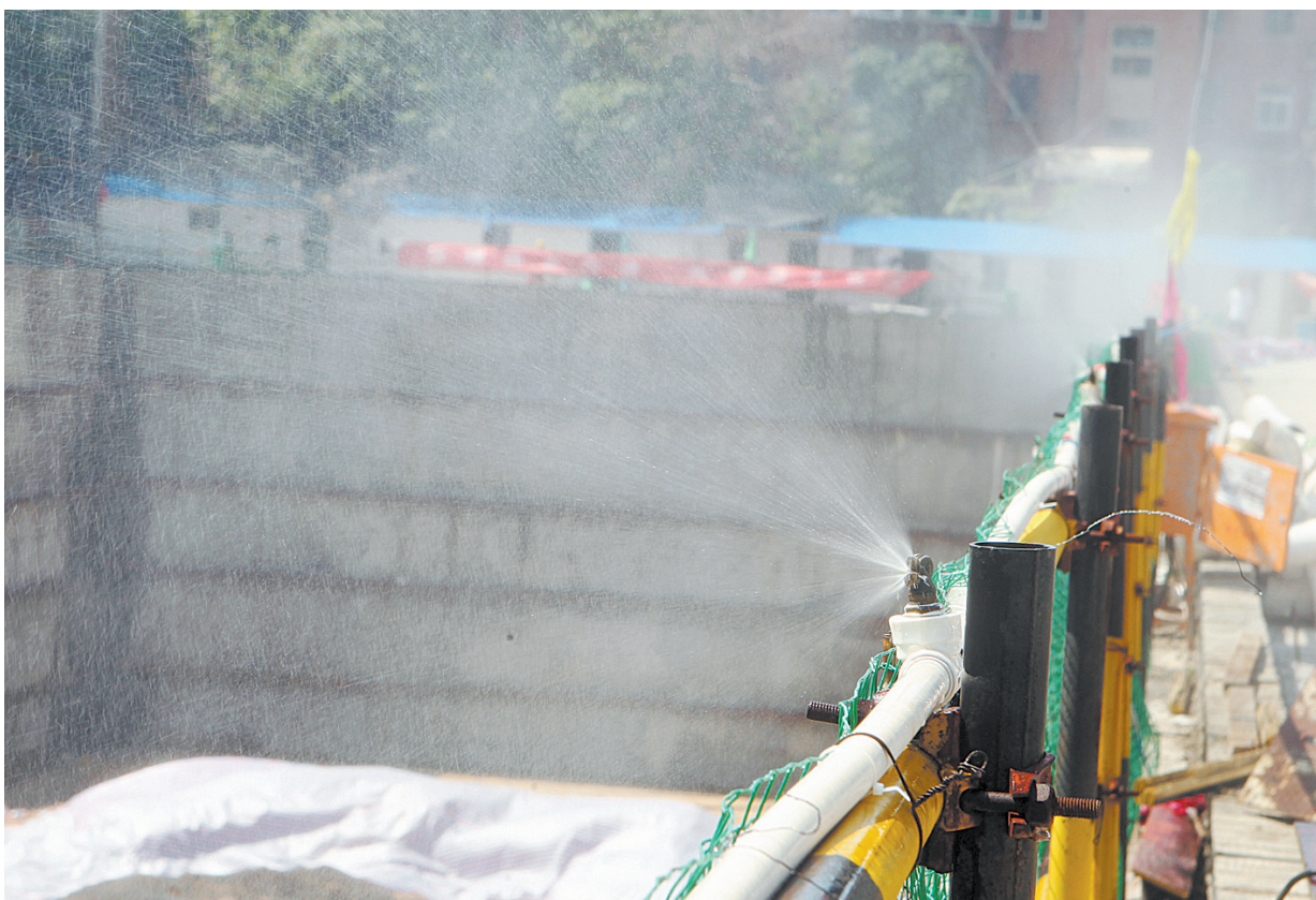
环绕喷淋 抑制扬尘
