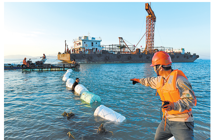
福建涠洲岛首条110千伏海底电缆敷设成功
