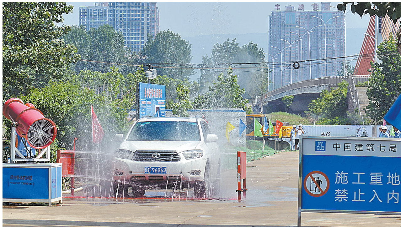
道路施工 抑尘先行
