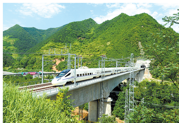
7月9日,一列高铁列车行驶在陕甘交界处的宝兰高铁东岔沟大桥上。新华社发
