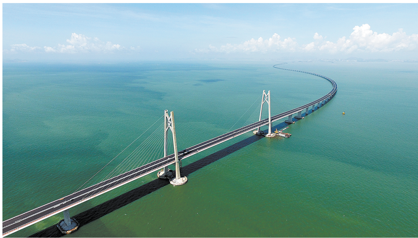
这是港珠澳大桥上的“中国结”造型桥塔(6月6日摄)。新华社发
