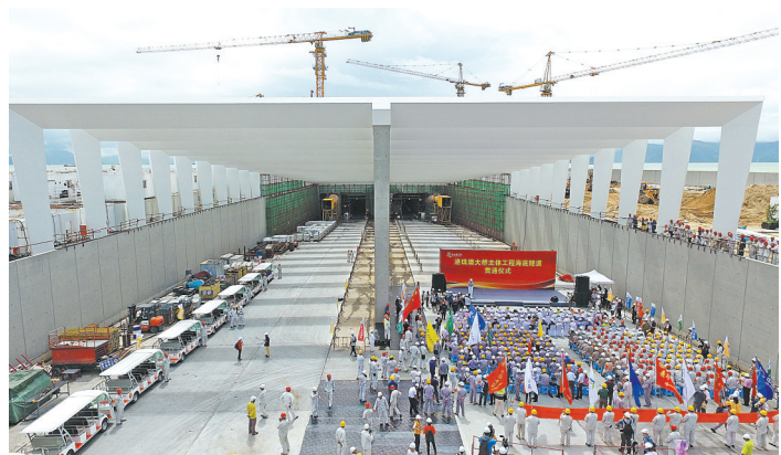
7月7日,贯通仪式在港珠澳大桥西人工岛隧道口举行。新华社发
