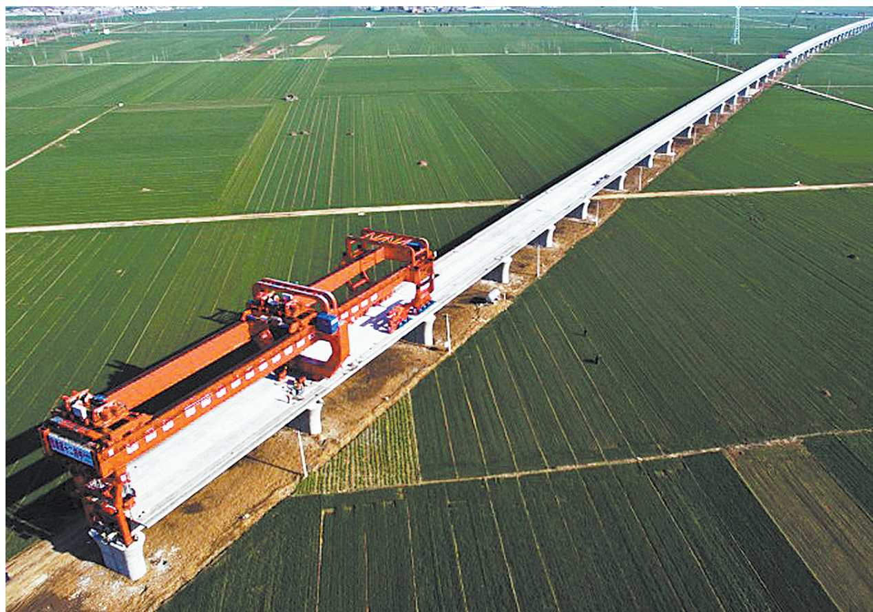
3月28日,工人们配合架梁机在宝丰县阎店镇境内的郑万高铁施工现场架设混凝土箱梁。 本报记者 王尧 摄
