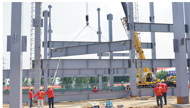
7月3日上午,工人在紧张施工。河南瑞贝佳生物科技有限公司新型生物营养制品及锂电池基础新材料项目去年落地宝丰县,一期工程预计今年10月底完工,随后进入试生产阶段。本报记者 牛智广 摄
