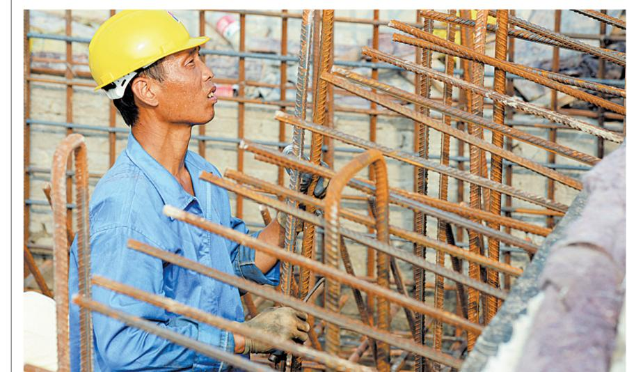
7月3日,一位工人在湛河治理工程许南路压坝施工现场调整钢筋间距。当日,我市最高气温突破35℃。湛河综合治理工程许南路压坝建设者克服高温天气影响,坚守岗位加快施工进度,努力争取项目尽早竣工。本报记者 王尧 摄
