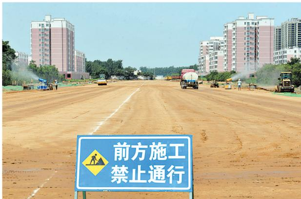
7月3日上午,施工人员和大型机械在湛河区长江路西段工程施工现场加工作业,一辆洒水车和两侧的雾炮在洒水、喷雾,为施工路段抑尘降尘。长江路西段全长1400米,是湛河区湛南新城道路建设计划中“三纵三横”中的一条东西主干道。为确保在修建道路的同时有效抑尘,防止施工扬尘造成大气污染,该工程从开工伊始就做好防尘抑尘工作,除对裸露施工土地加盖防尘网、设立车辆冲洗设施外,同时喷雾、洒水抑尘。
