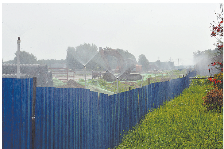
6月29日上午,施工人员和大型机械在高新区新南环路东延工程施工现场加紧施工作业,新建道路两侧围挡上的喷雾装置在不停地喷雾抑尘。新南环路东延工程(叶宝路至许南路段)是我市“打通断头路、畅通微循环”重点工作的一条新建道路,全长1800米。该工程从开工伊始就做好防尘抑尘工作,除对裸露施工土地加盖防尘网、设立车辆冲洗设施外,同时喷雾、洒水抑尘,尽量做到防尘、抑尘无死角。本报记者 牛智广 摄
