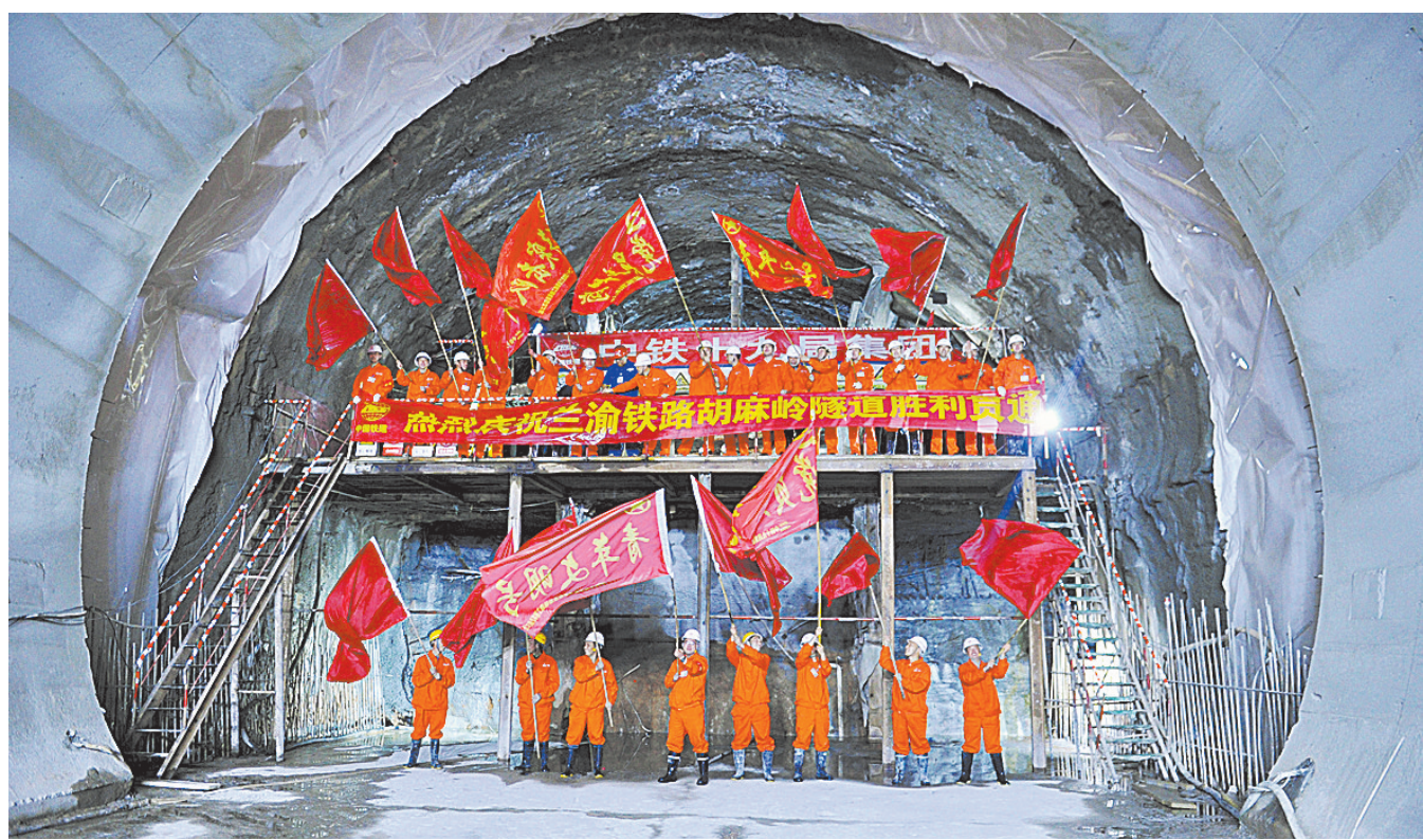
兰渝铁路最后一座隧道顺利贯通
