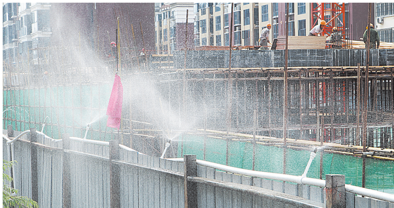
6月19日,市区园林路中段一个在建项目工地外墙上的喷淋系统向工地喷洒水雾,抑制扬尘。 本报记者 姜涛 摄
