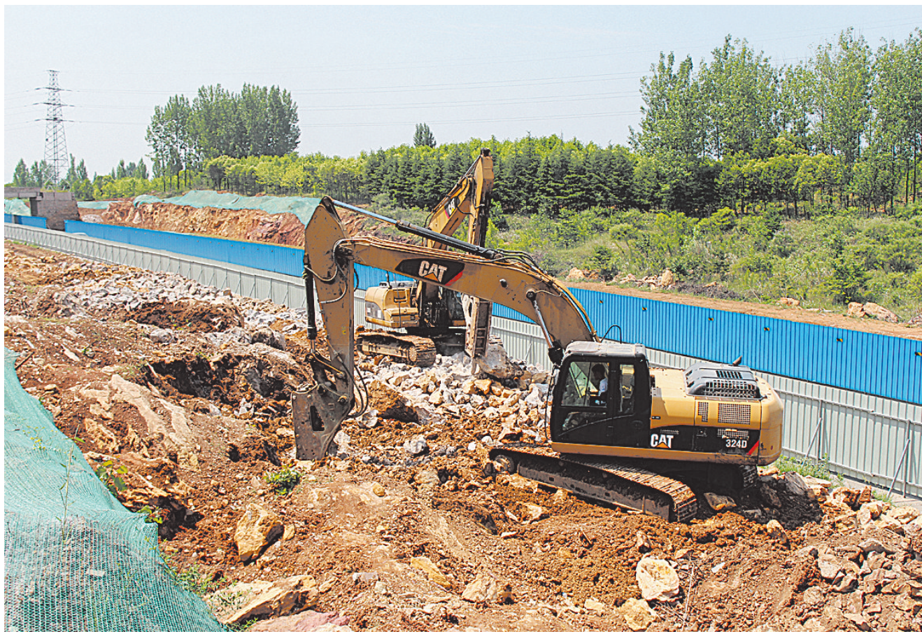
郑尧高速鲁山站出入口连接线改造项目加速推进
