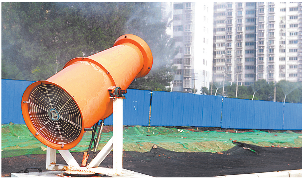
6月15日,未来路北延工程工地同时开启远程雾炮和围挡喷淋装置,对工地内部区域实施交叉抑尘作业。 本报记者 王尧 摄
