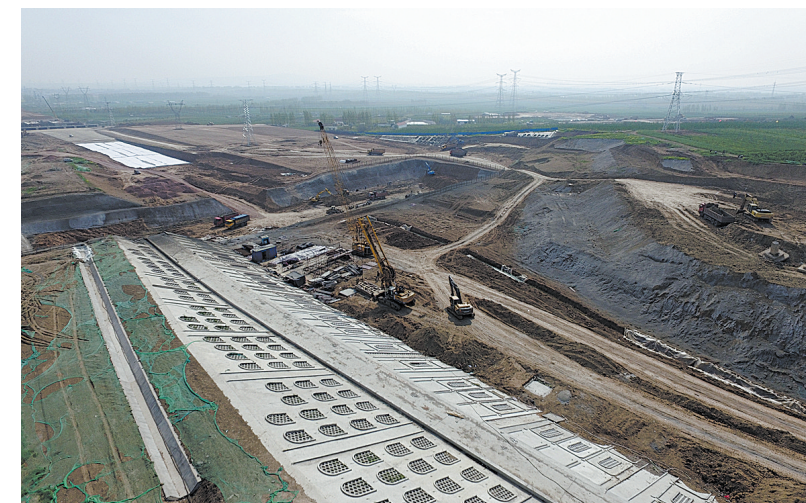
郑万高铁平顶山西站施工现场 何五昌 摄
