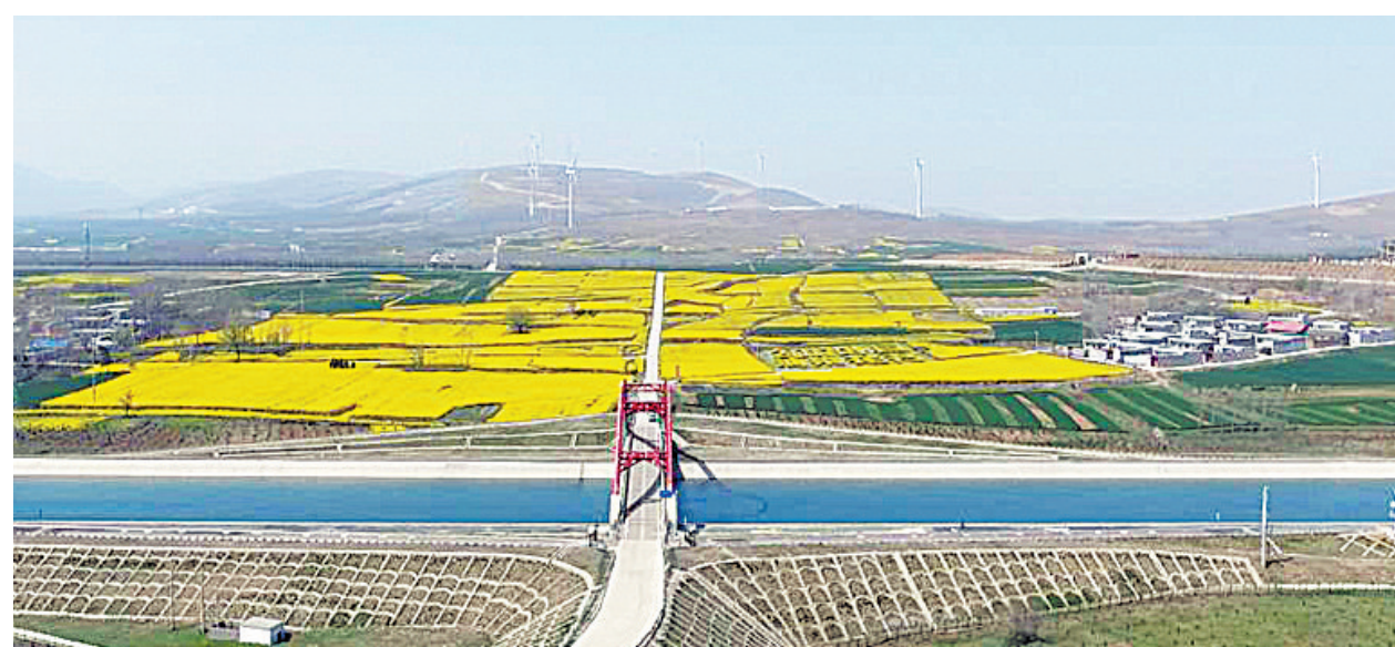
南水北调中线工程叶县境内干渠沿线
