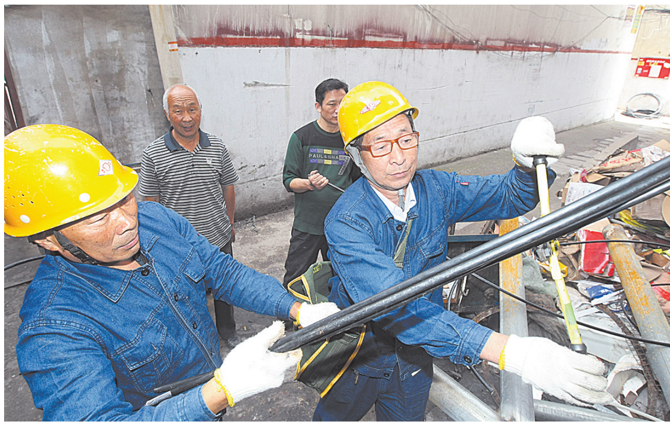
实施煤改电工程
