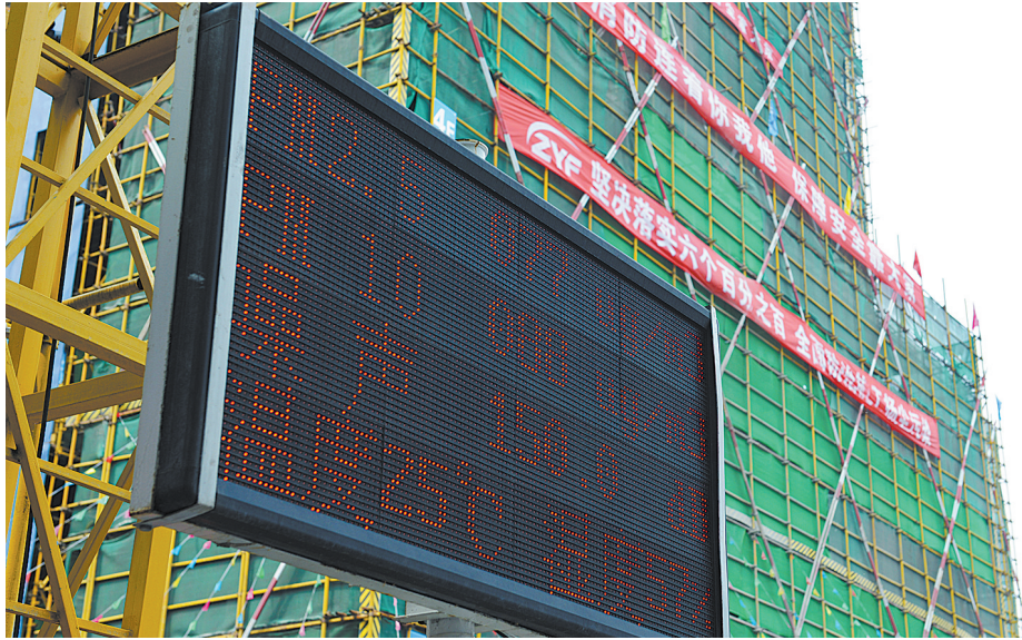
6月11日,市区迎宾路中段某项目工地通过设置在出入口处的电子屏对外显示主要环境数据。为做好大气污染防治工作,该项目施工单位按要求安装了扬尘在
