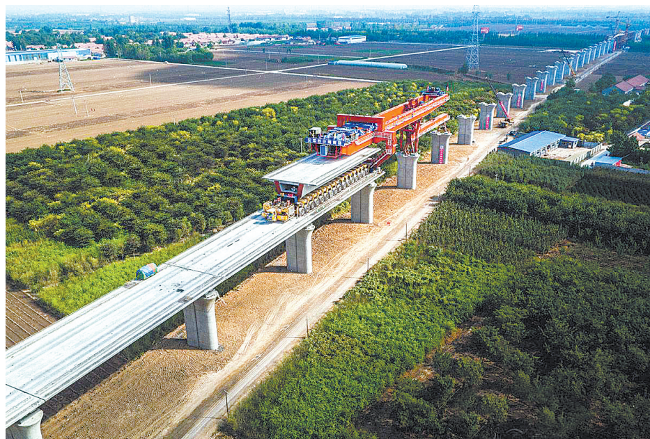
郑万高铁石桥段制架梁作业
