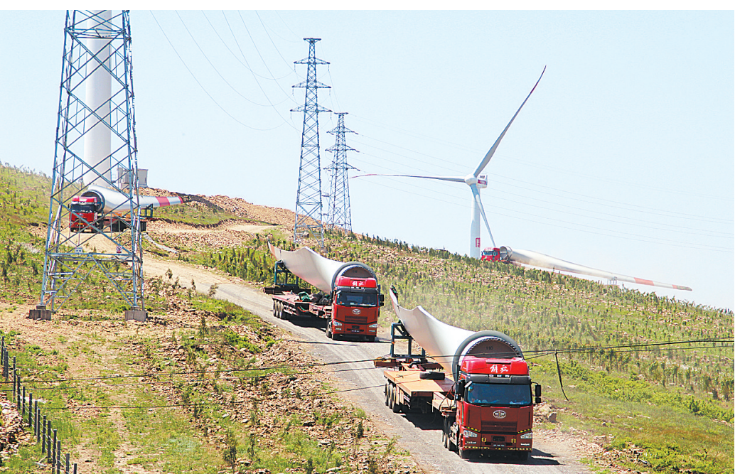
大唐红石山风电项目正在施工
