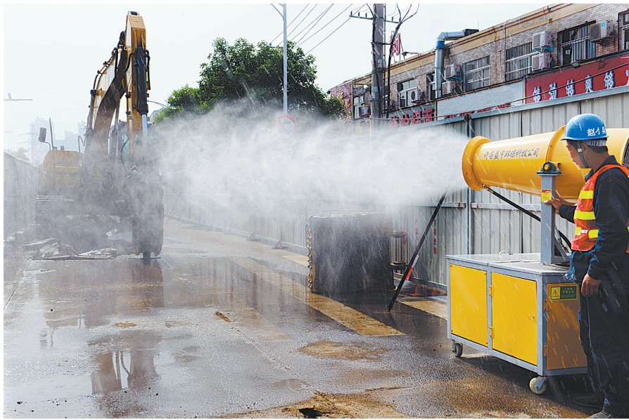
湿法作业防扬尘
