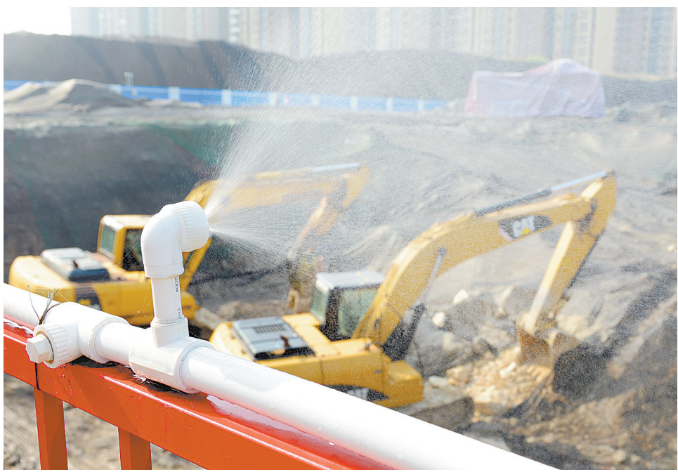
5月24日,城乡一体化示范区东滨安置小区项目建设单位用防尘网对基坑外立面进行覆盖,并在土方施工期间启动喷淋装置对开挖区域实施水雾抑尘作业。 为做好环境污染防治工作,城乡一体化示范区东滨安置小区建设单位用防尘网对工地内部区域和基坑外立面进行全面覆盖,并在土方施工期间启动喷淋装置对开挖区域进行水雾抑尘作业。 本报记者 王尧 摄
