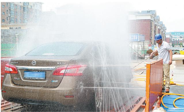
5月22日,一辆机动车在市区园林路路段一个工地出口处进行冲洗。为了做好大气污染防治工作,避免车辆携带泥土造成扬尘,该项目施工方在施工现场出口处安装了重力感应喷淋系统,对所有出工地的车辆进行喷淋清洗。本报记者 姜涛 摄
