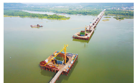
5月22日,中国铁建二十二局的工人在蒙华铁路赣江特大桥施工。
