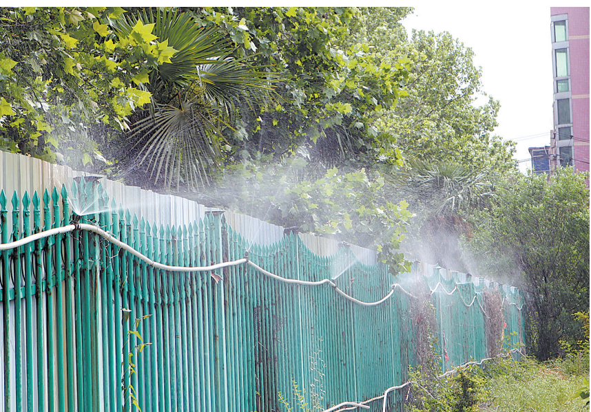
5月12日,建设路东段一个在建项目工地外墙上的喷淋系统向工地内外喷洒水雾,抑制扬尘。为有效避免扬尘,该项目建设方在工地围墙上设置了喷淋系统,防止施工扬尘造成大气污染。
