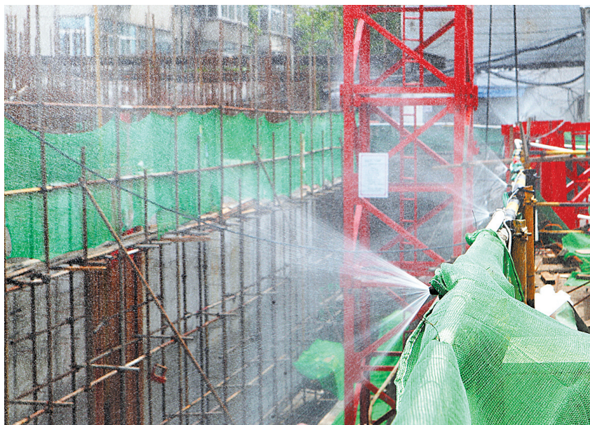
环绕喷淋 抑制扬尘
