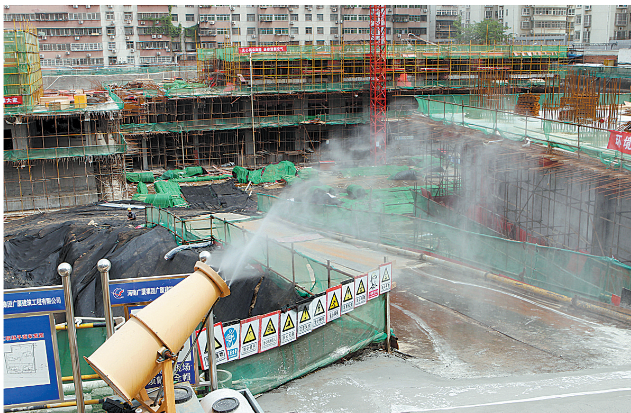
5月7日,市区建设路东段某项目建设工地在利用远程雾炮机喷雾降尘,监测系统在对工地扬尘情况实时进行监控。为了防止施工造成大气污染,有效避免扬尘,该项目施工方购置了远程雾炮机对工地进行喷雾降尘,并自行安装了扬尘监测系统实时监控各项数值,做到了多措并举抑制扬尘。本报记者 姜涛 摄
