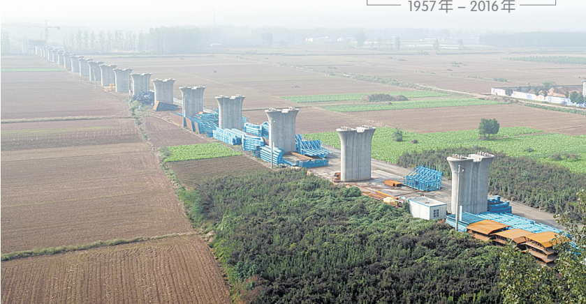
郑万铁路鲁山段加紧施工
