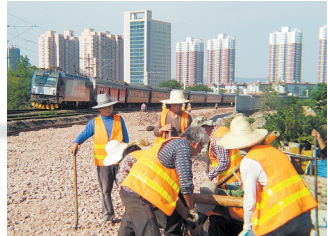
孟平铁路电气化复线改造即将完工
