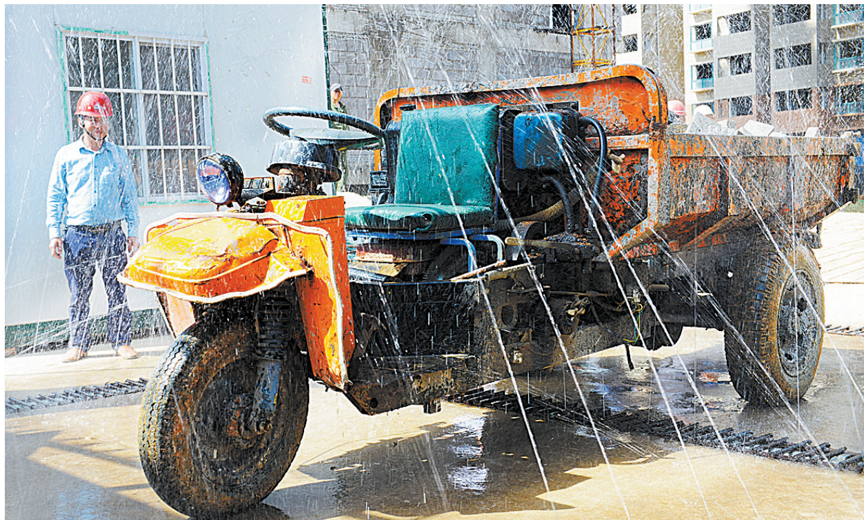
4月26日,值班人员在平顶山新型耐材股份有限公司保障房项目工地出口处开启喷淋装置,对一辆运料车进行冲洗除尘作业。
