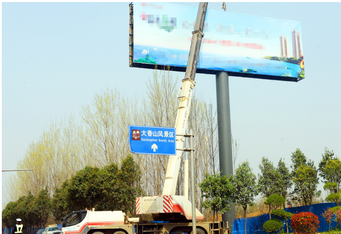
拆除违法广告牌
