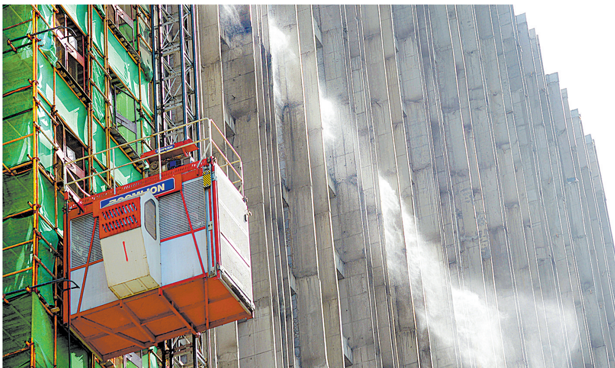
4月24日,平顶山饭店原址改造项目工地开启高空喷雾装置进行抑尘作业。
